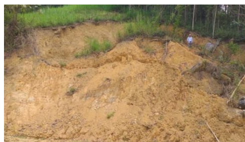
Hình 3b. Điểm trượt tại Km34+300 tỉnh lộ 14B trên vỏ phong hóa đá trầm tích hệ tầng Cô Bai.
