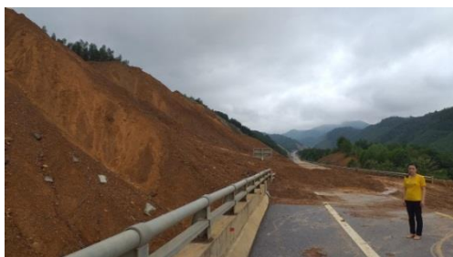
Hình 2a. Điểm trượt tại Km22+700 cao tốc La Sơn - Túy Loan trên vỏ phong hóa đá trầm tích biến chất hệ tầng Long Đại.
