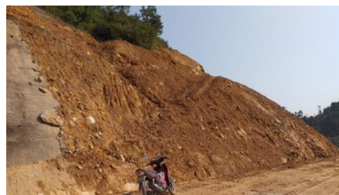
Hình 2b. Điểm trượt quy mô lớn tại Km25+800 cao tốc La Sơn - Túy Loan trên vỏ phong hóa đá trầm tích biến chất hệ tầng Long Đại.
