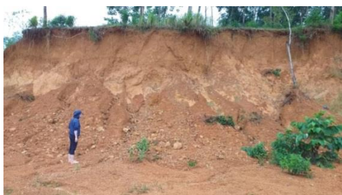
Hình 3a. Điểm trượt tại Km31+500 tỉnh lộ 14B trên vỏ phong hóa các đá phức hệ Chaval.
