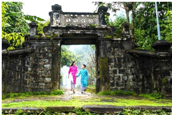
Hình 4. Cổng đá nhà ông Nguyễn Hào, Tiên Cảnh xây dựng năm 1940 (Bùi Viết Hà).
