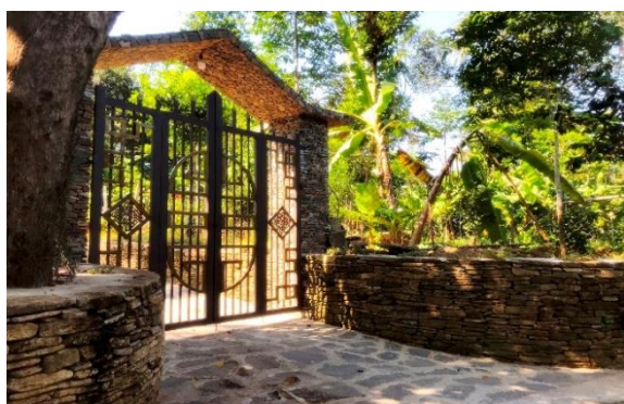
Hình 6. Cổng nhà ông Đoàn Miết, xây dựng năm 2019 (Kim Thiện).
