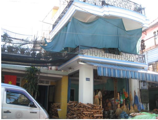
Hình 15: Nhà Phụ 3 tầng của ngôi nhà C11 (102 Ngô Đức Kế) đã phá vỡ điểm nhân của Nhà Chính
